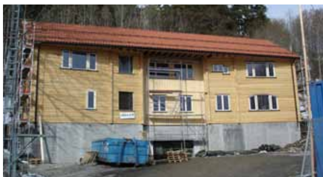
Helsepedagogisk skole i Oslo har bygget nytt skolebygg på Ljabru med lån fra Cultura og Ekobanken.
